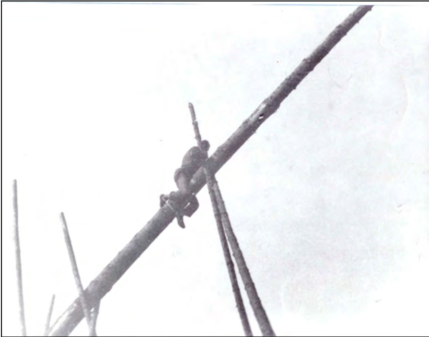
Eugen Krause auf dem Maibaum, während der Reparatur der Schere, Pfingsten 1929.
